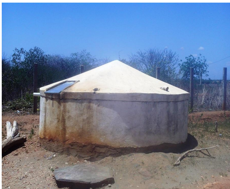
Foto 13: Cisterna de Placa coletiva durante os períodos de estiagem, para a captação e armazenamento da água da chuva. Foto da autora, Jan 2015.
